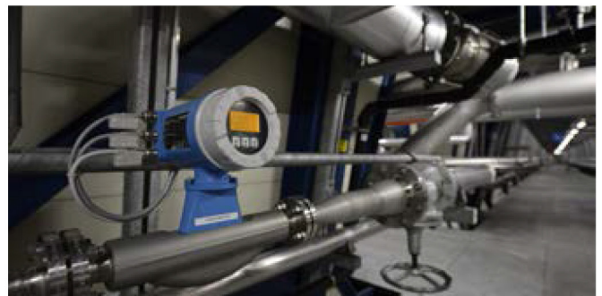
Medición de densidad Coriolis en el proceso de acondicionamiento de lodos con un dispositivo Promass
