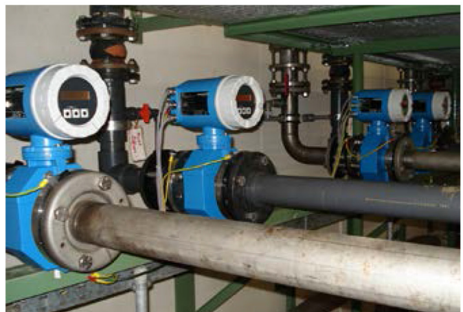
Control confiable de caudales con el caudalímetro electromagnético Promag
