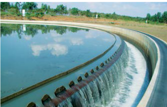
Tratamiento de aguas residuales municipales
