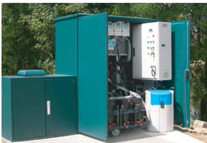
Estación compacta de monitoreo de cuerpo acuoso con solución de contenedor
