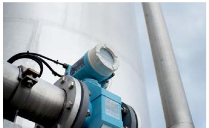
Tratamiento de aguas industriales y aguas residuales
