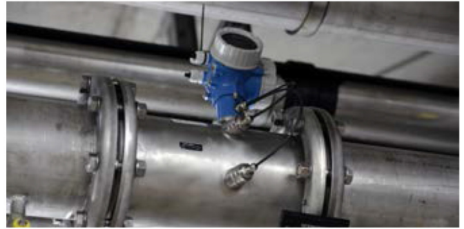
Medición ultrasónica de caudal y contenido de metano en biogás con Prosonic Flow B 200
