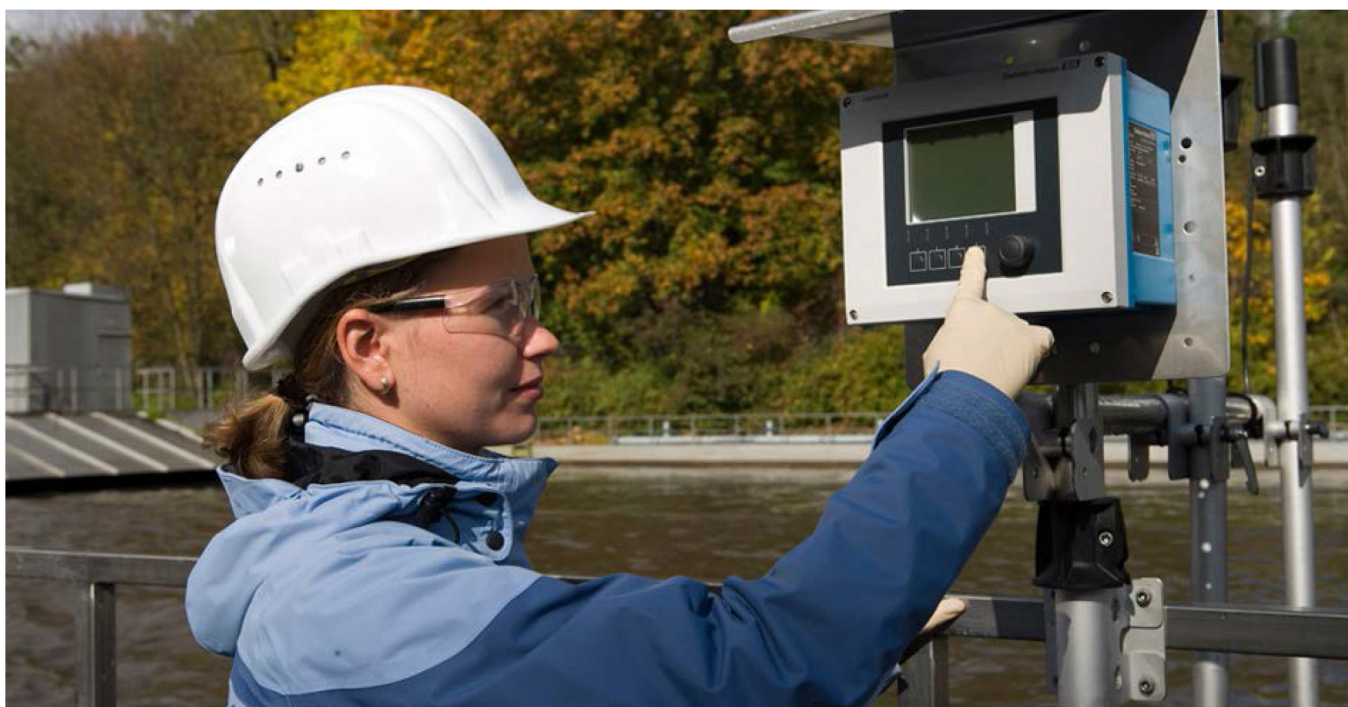
Análisis en línea con el transmisor Liquiline CM44x es la base para una mayor optimización en el tratamiento biológico
