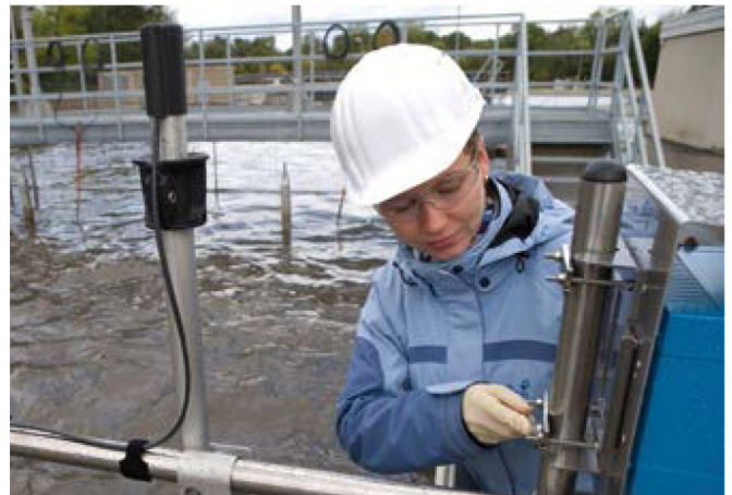
Nuestros expertos proporcionan soporte técnico para el funcionamiento terso de las plantas
