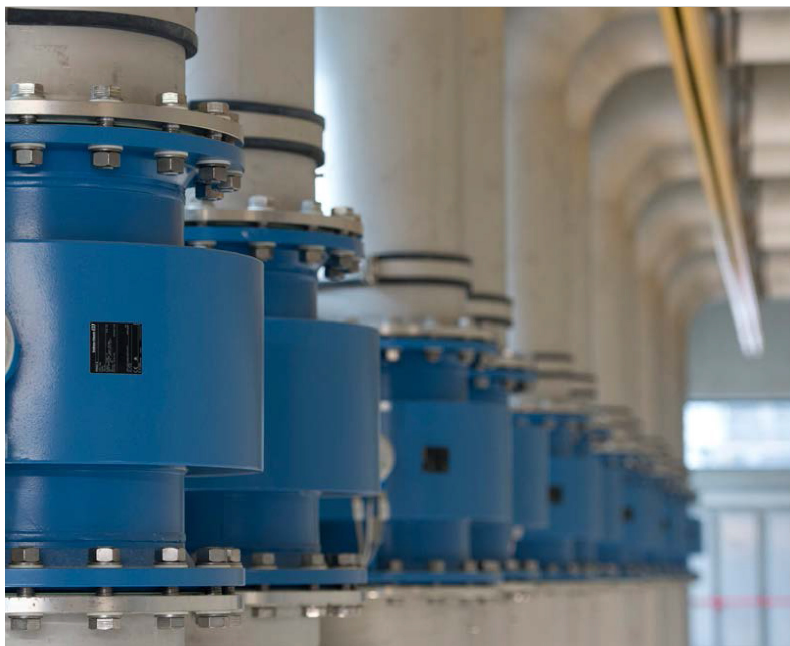
Medición de caudal de agua, aguas residuales o lodos: El método de inducción electromagnética de medición de caudal es la norma
